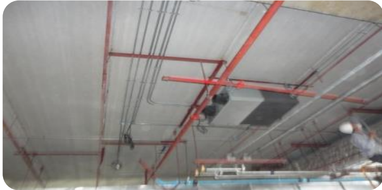
Project : Minebea Lopburi new factory Client : Azbil (Thailand) Co., Ltd.
